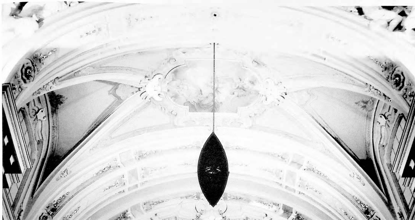
Le strutture all'interno della basilica.
